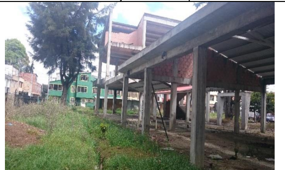
Salón Comunal Los Monjes – Vista posterior 1er piso
