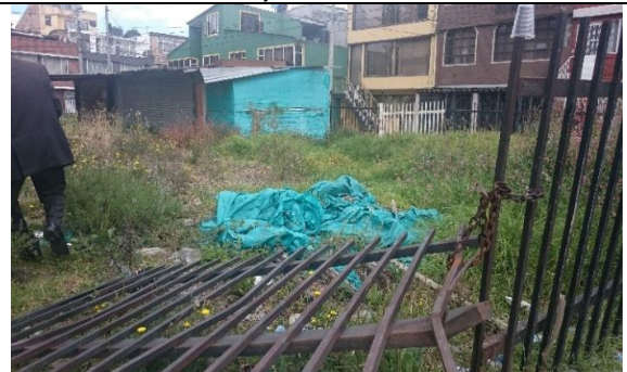
Salón Comunal Los Monjes – Parte de puerta de acceso
