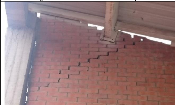
Salón Comunal Los Monjes – estado del 2º piso
